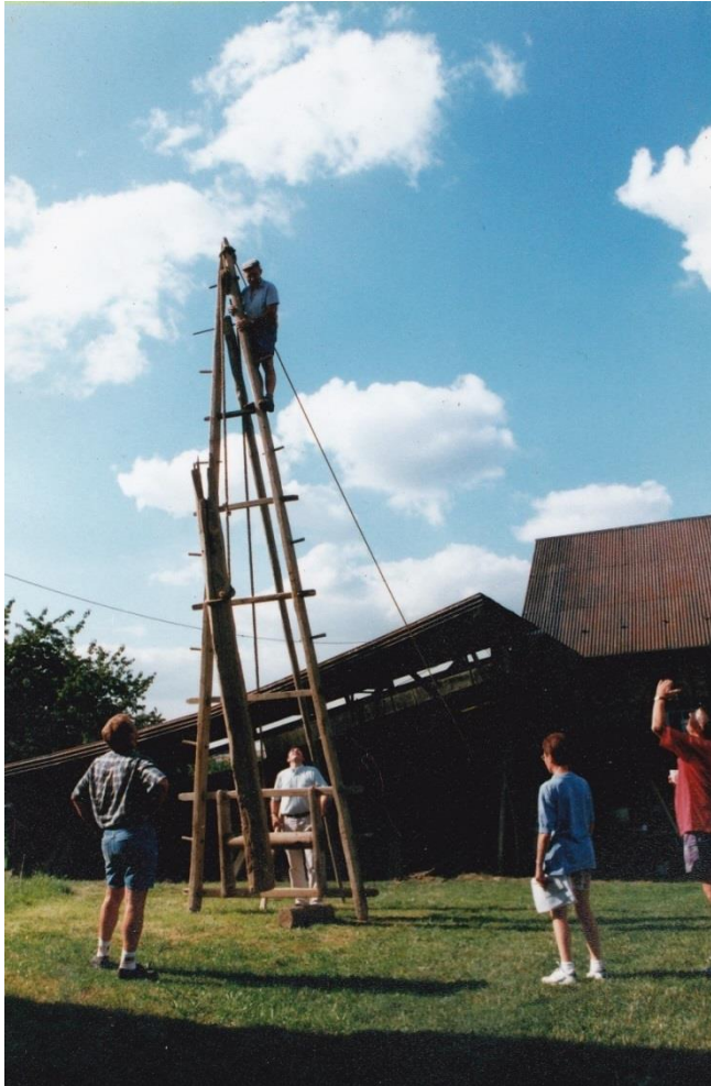
A Wadimont, Monsieur Canard, ancien charpentier, perché en haut de sa chèvre.
